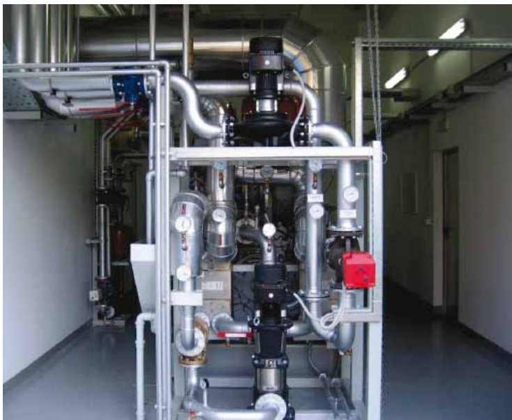
Priključek kogeneracije na toplovodno omrežje
