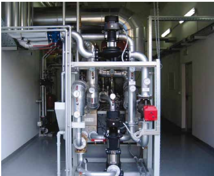
Priključek kogeneracije na toplovodno omrežje
